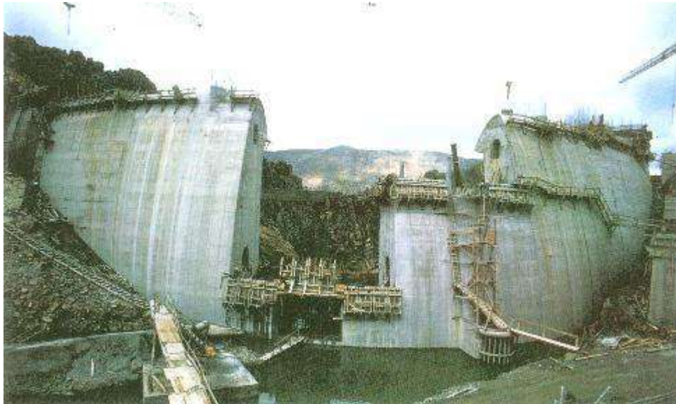
Detalhe da construção da barragem "Caldeirão", em Portugal (EDP).
